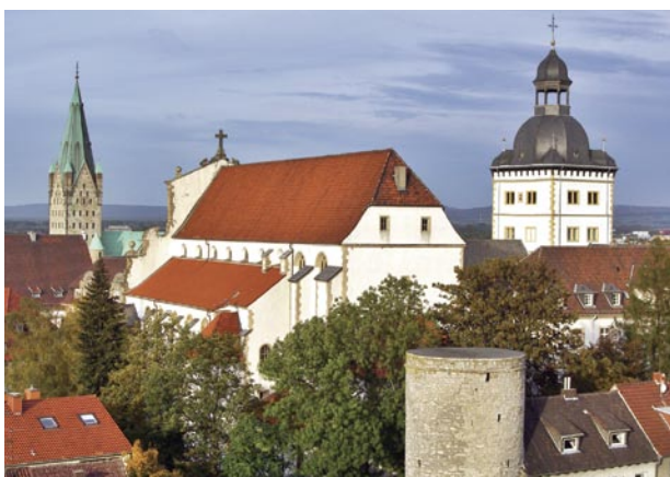
Kreis Paderborn setzt auf IT-Grundschutz.
