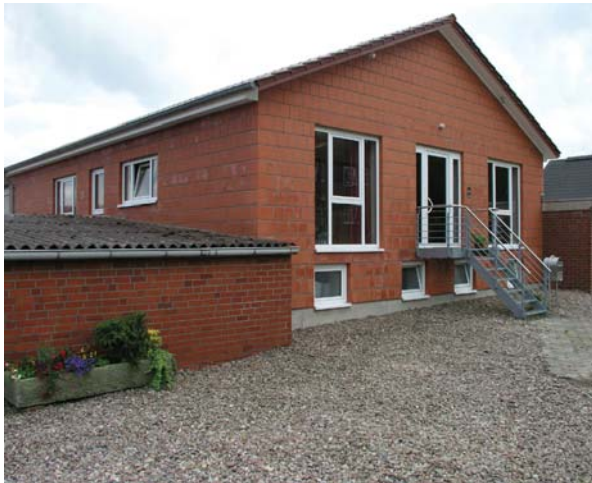
Das Geschäftsgebäude von Meier-Brakenberg im Extertal
