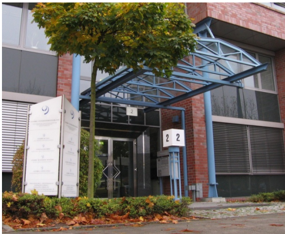
Das Firmengebäude der Gehrke & Coll. Steuerberatungsgesellschaft in Hannover
